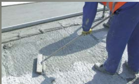
Wyrównanie gradientowe na moście – aplikacja mostka szpenego EuroCret® MKH...
