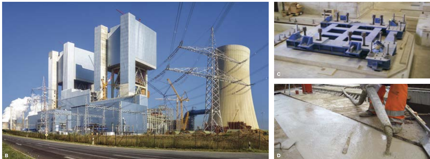
A i B. Budowa elektrowni Neurath | C. Fundament pod maszynę przed procesem podlewania | D. Zalwanie w ramach budowy mostu
