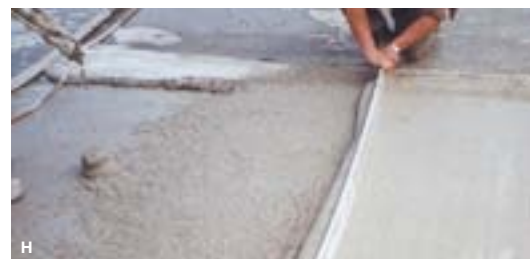
E. Komin przemysłowy przygotowywany do renowacji za pomocą EuroCret® 40 HSF | F. Podpora mostu jest powlekana EuroCret® 20 | G. Rozkute uszkodzenie podpory betonowej | H. Gradientowa niwelacja na moście z użyciem EuroCret® 40
