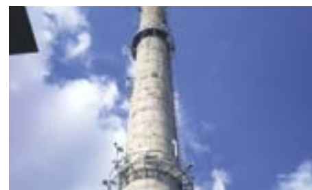
Renowacja komina przy pomocy systemu zapraw naprawczych EuroCret®
