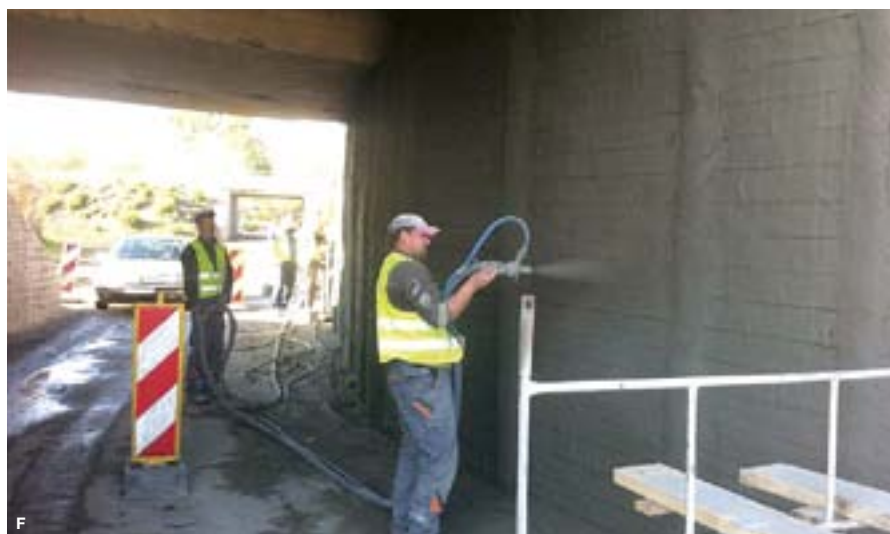
E. Komin przemysłowy przygotowywany do renowacji za pomocą EuroCret® 40 HSF | F. Podpora mostu jest powlekana EuroCret® 20 | G. Rozkute uszkodzenie podpory betonowej | H. Gradientowa niwelacja na moście z użyciem EuroCret® 40
