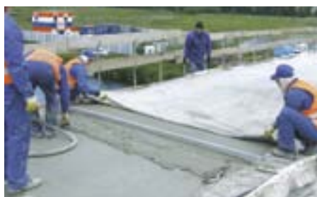
... układanie i zabezpieczanie zaprawy naprawczej EuroCret
