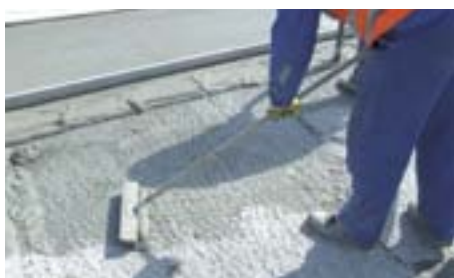
Wyrównanie gradientowe na moście – aplikacja mostka szcypnego EuroCret® MKH...
